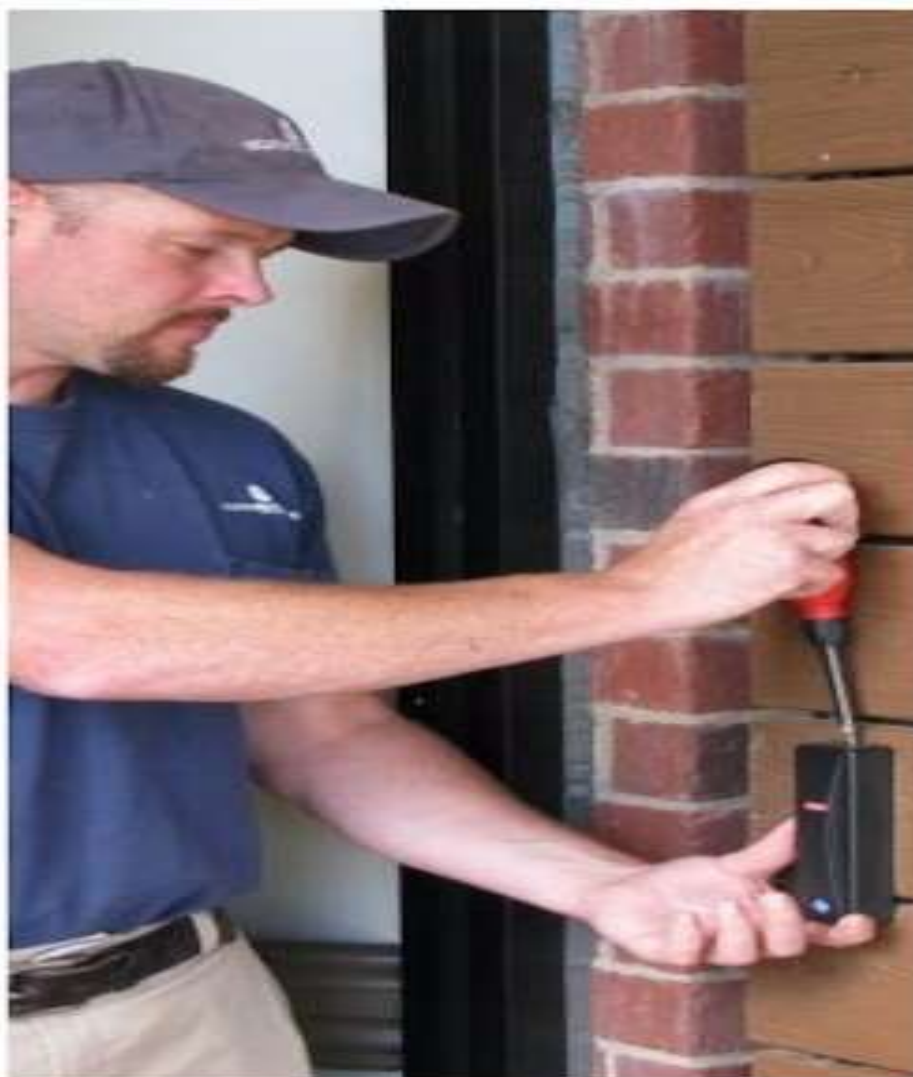
Рисунок 9 – монтажа считывателя
