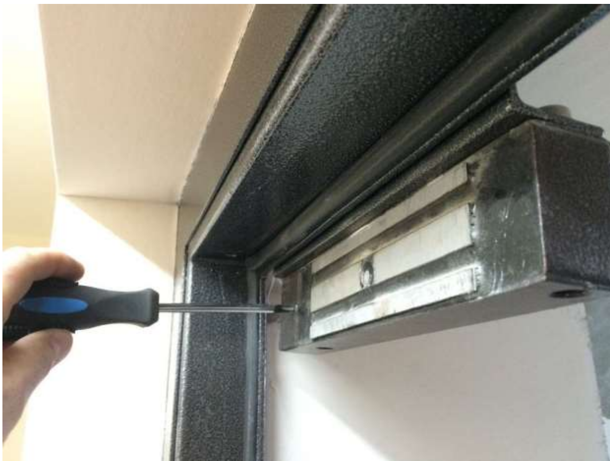
Рисунок 8 – установка электромагнитного замка
